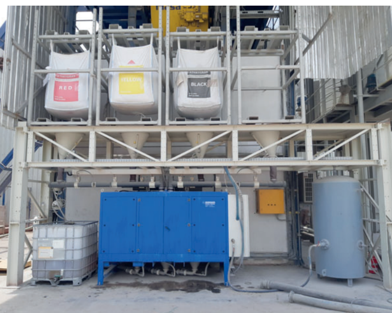
COM 70-3-Granulanlage mit 3 Sendegefäßen
