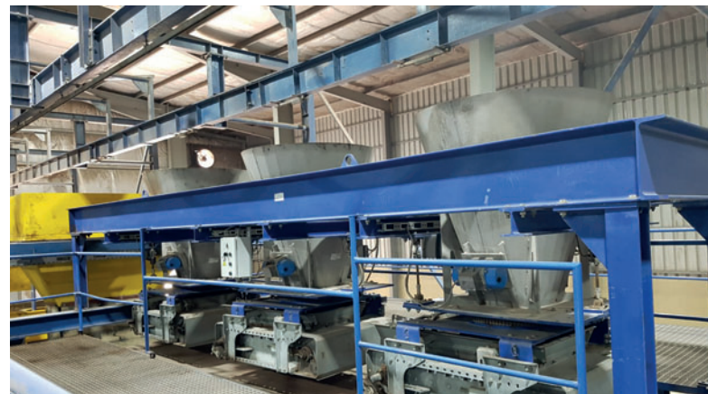
Trichter für unterschiedliche eingefärbte Betone für Vorsatzpflaster
